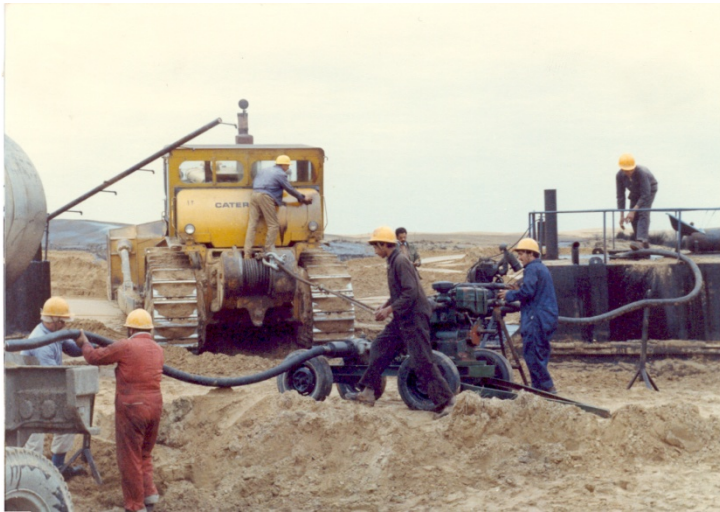
شکل شماره ۶-۳- تخلیه مالچ از تانکر به اسکی از طریق پمپ
