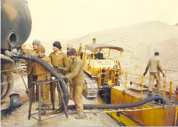
شکل شماره ۶-۲- تخلیه مالچ از تانکر به اسکی از طریق ثقلی
