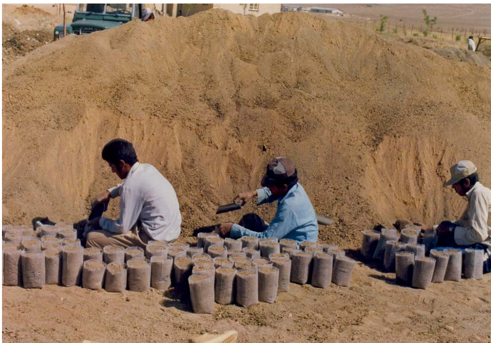
عکس شماره ۳-۲- پر کردن گلدان‌ها با استفاده از نیروی کارگر
