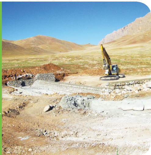
شکل ۱ عملیات اجرایی بند انحرافی سیستم قنات معکوس
