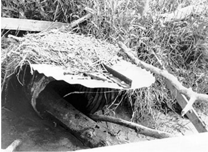
عکس شماره ۱۴ - جمع شدن مواد زائد و شناور و مسدود شدن دهانه سرریز لوله ای
