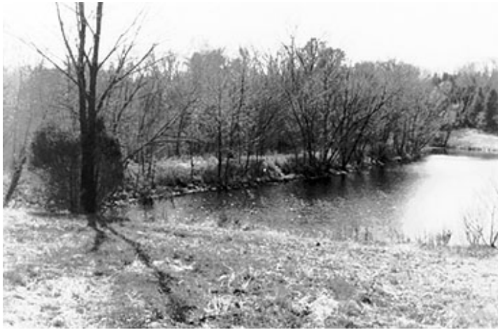
عکس شماره ۱۲- رشد درختان و گیاهان خشبی روی سد یا دهانه سرریز (باعث تخریب)
