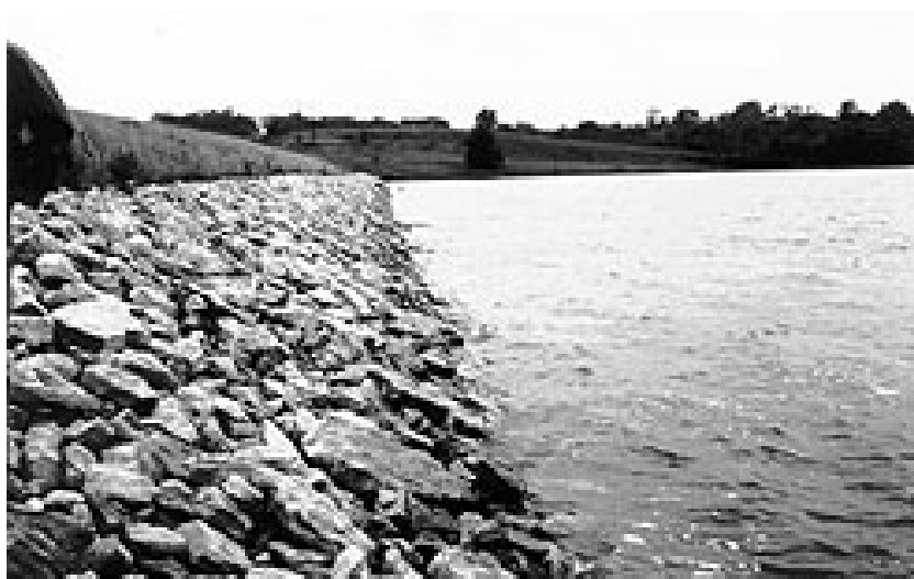
عکس شماره ۱۰ - استفاده از ریپ ریپ در حفاظت بالادست سد بخصوص در سدهای با مخازن وسیع در معرض باد
